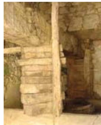
El otro extremo de la viga se podía mover a lo largo de unas guías. Por medio del uso se podía subir y bajar la viga de madera.
