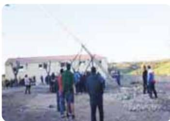
hacía un hoyo e introduciendo en él la parte de abajo y mediante sogas y palos haciendo una especie de aspa se iba poniendo de pie. No había ninguna máquina para levantarlo.
